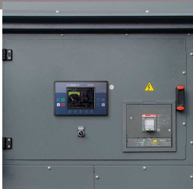
> Cuadro de sincronización con unidad de control ComAp IG1000
